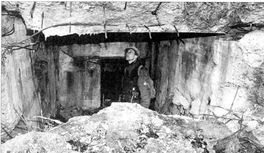
Denkmalverlust: Diesen Bunker in Kerschenbach (Eifel) ließen lokale Entscheidungsträger eigenmächtig mit Erde zudecken. Bunkerforscher wie Patrice Wijnands (Bild) kritisieren so ein Vorgehen scharf.
